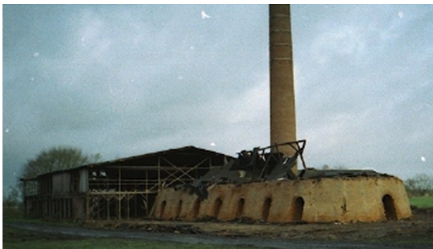
Den blottede ringovn ved nedrivningen i 2001 .
